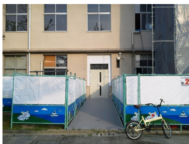
回流水槽へ入るための新設扉
