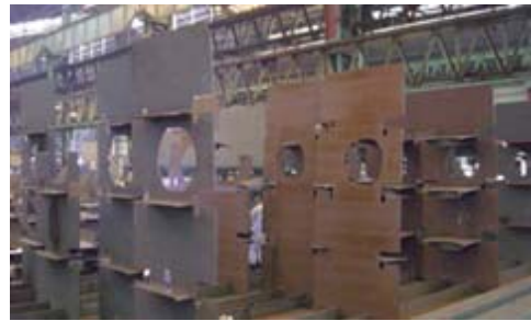
内業工場内 小組ブロック
