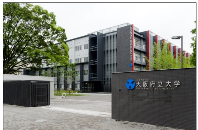
中舌鳥門からサイエンス棟を望んだところ
