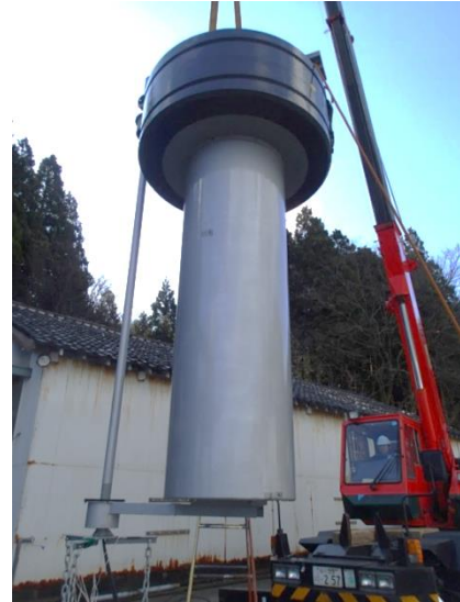
写真4：石川県穴水町における浮体式洋上風車の 実証試験写真1（クレーンでインストール中）
