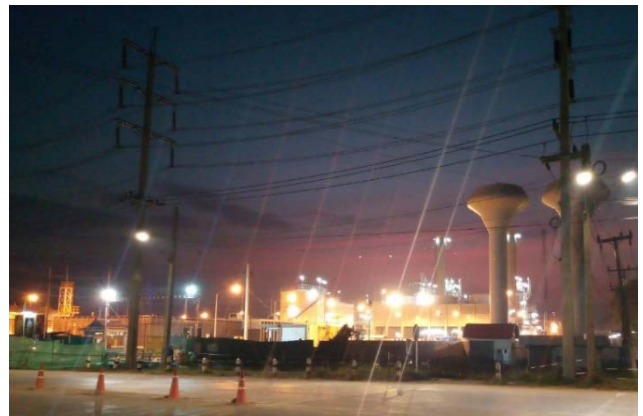
総出力130MWの現場。そのうち90MWはタイ発電公社に売電、40MWは地域の一般企業に売電されます。
